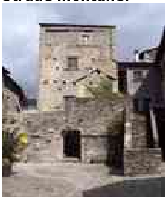
Casa Torre di Ponticello
