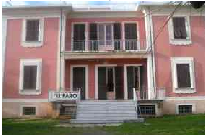
Figura 2 Struttura che ospita il "Nido delle cicogne" a Terrarossa
